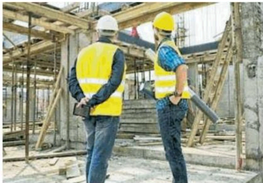
Lavori in corso all'interno di un cantiere edile (foto d'archivio)
